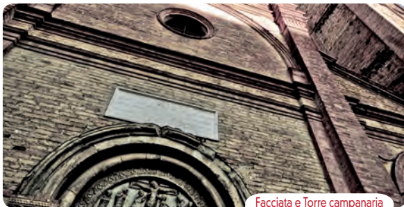
Facciata e Torre campanaria
